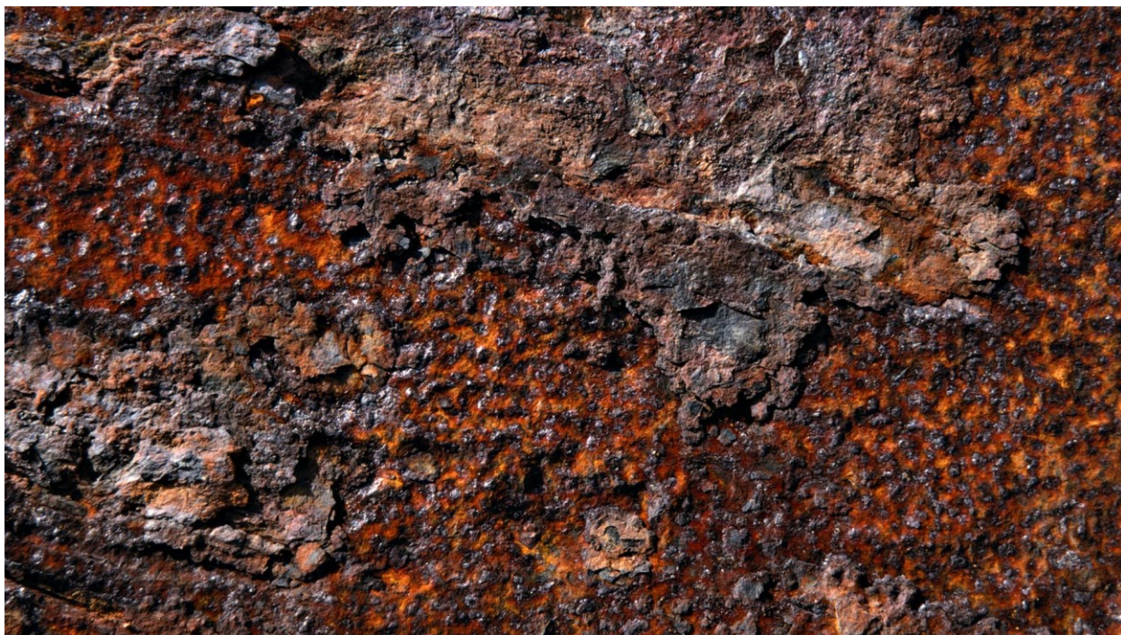
Рисунок 3 – Поверхность металла, покрытая ржавчиной
